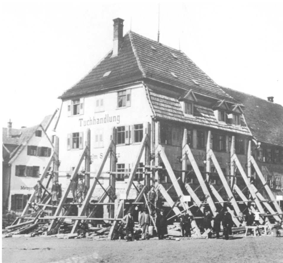
92 Gebäude Bahnhofstraße 1 während der Hebung
